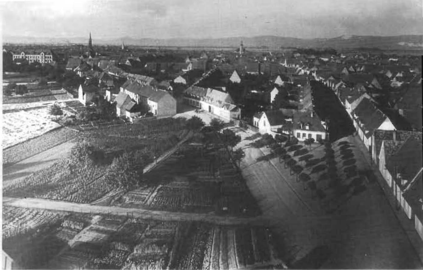
Blick vom Wasserturm
