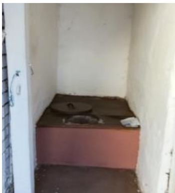
„Abtritt“ in der Rastatterstraße Foto: H. Knorr
